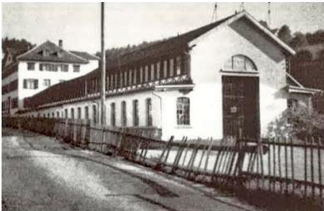
Abbildung 5 Die Fabrikhalle von Westen 1953
