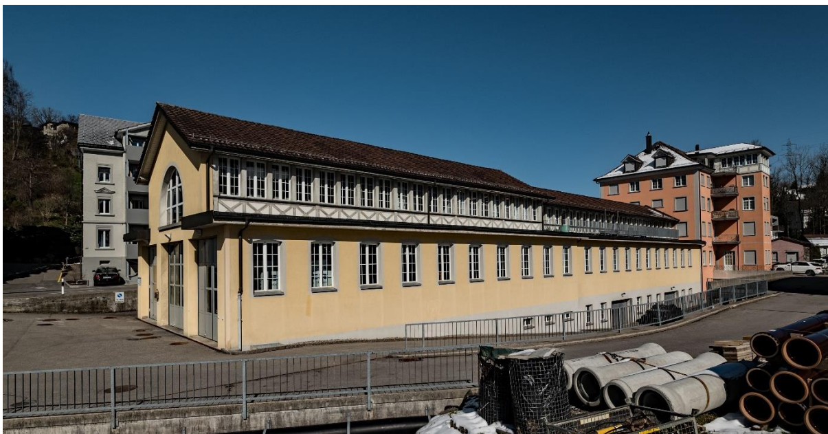
Abbildung 14 Die Gebäude der Maschinenfabrik am 8. April 2021, ganz rechts das Haus mit dem Walmdach, in der Mitte die Fabrikhalle, beide von Weniger erstellt, links der westliche Anbau von Gottfried v.Süsskind erbaut, Sicht von Südwesten im April 2021
